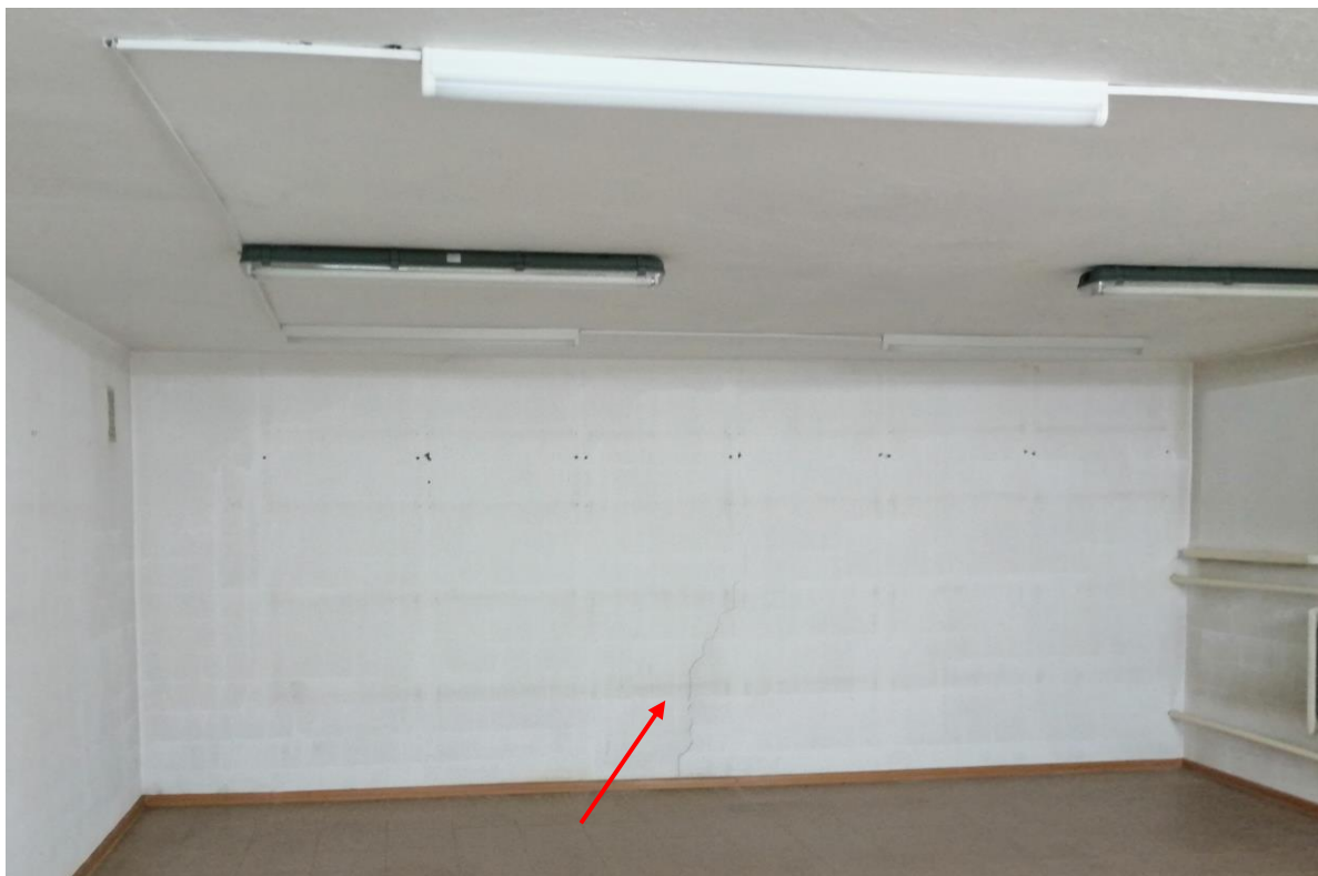
Zdjęcie 5.: Zarysowania odcinków ściany szczytowej – przyziemie (0,3-2mm)
