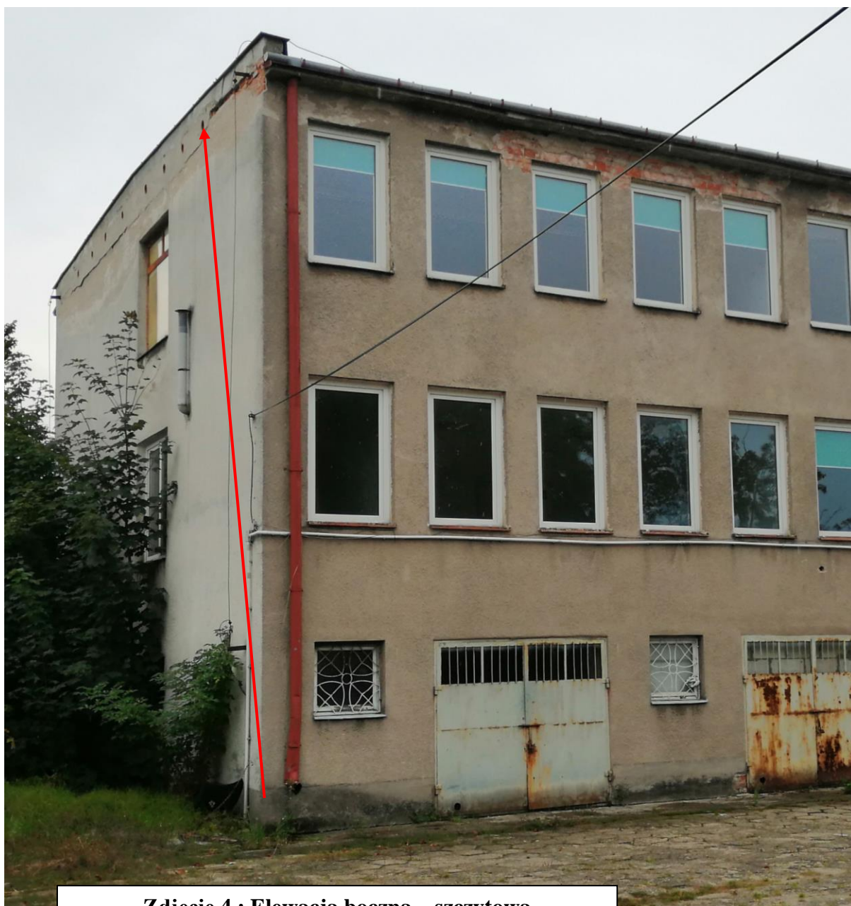
Zdjęcie 4.: Elewacja boczna – szczytowa Widoczne odspojenie ścian attykowych
