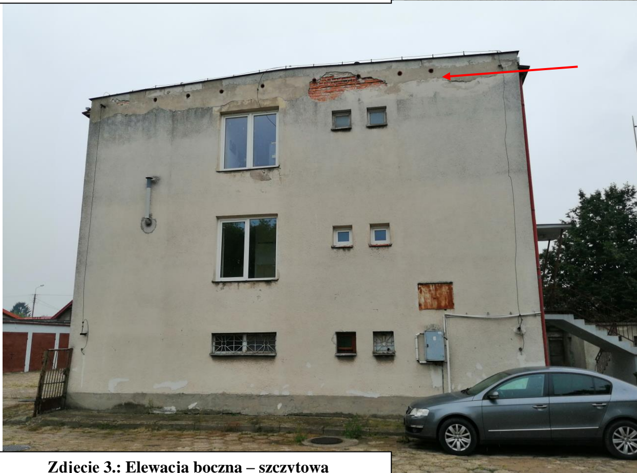
Zdjęcie 2.: Elewacja boczna – szczytowa Widoczne odspojenie ścian attykowych
