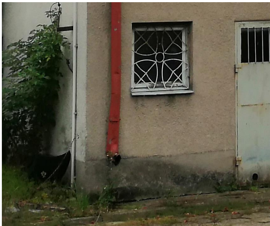
Zdjęcie 1.: Przyczyny zawilgocenia ścian fundamentowych - przyziemie
